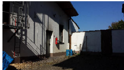
Abbildung 44: Heizungsraum der Feuerwehr Oberhaid
